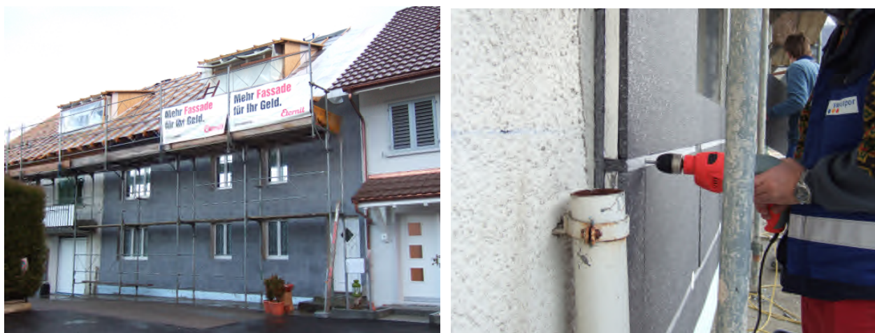
Abbildung 3: Links – Fassade für die Pilotmontage Rechts – Bohren der Löcher in den horizontalen Montagestreifen. Bilder: FHNW
